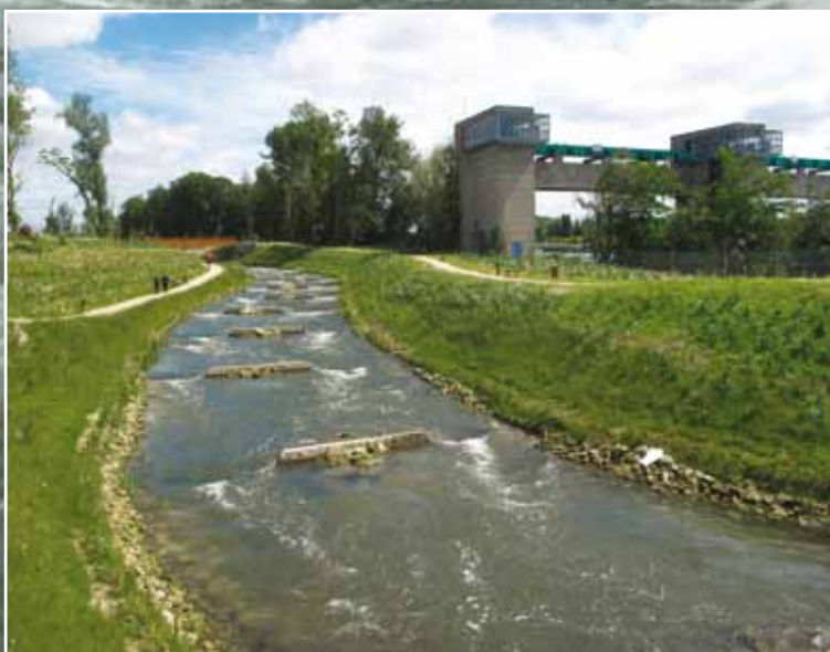
Passe à poissons du barrage d'Andrézy
